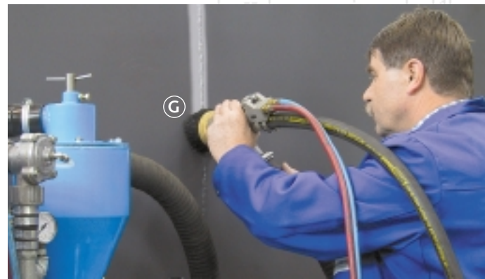
Manuelles Handling des Strahlkopfes bei der Schweißnahtreinigung
